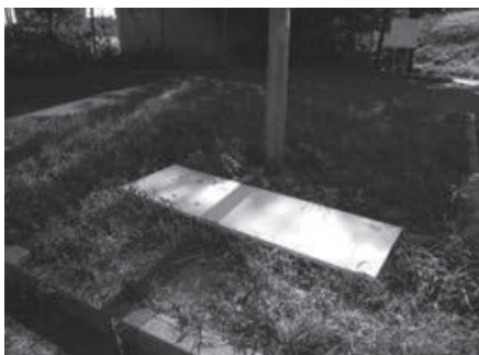
東海ふ頭公園の様子（監査人撮影） （白い板状の物が放置されていた。）
