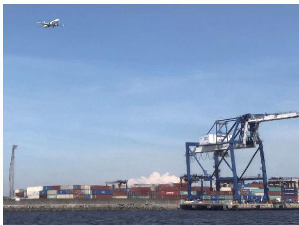
中央防波堤外側コンテナふ頭（船上より） （航空機の安全のためクレーンの高さ制限がある）
