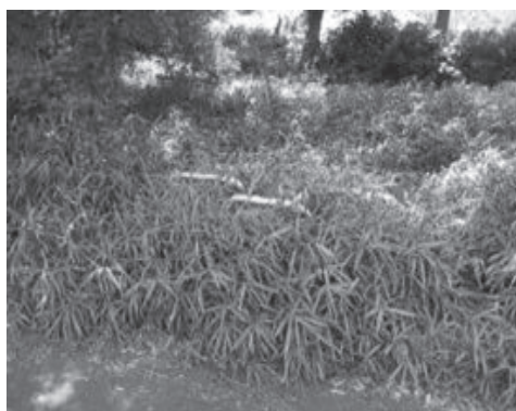
東海緑道公園の様子（監査人撮影） （エントランスが雑草に覆われ、通行が困難。）
