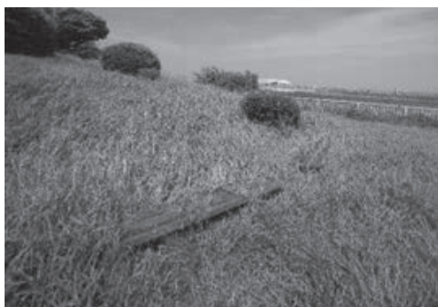
京浜島緑道公園の様子（監査人撮影） （ベンチ付近が雑草に覆われており、本来の目的での使用が困難。）
