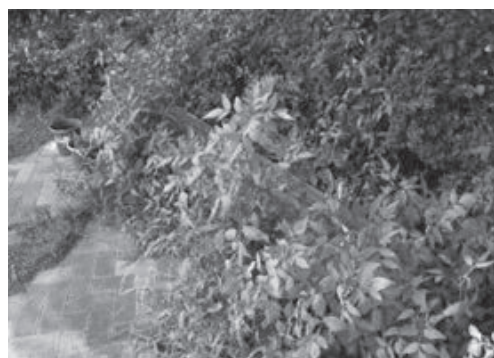
東海ふ頭公園の様子（監査人撮影） （ベンチ付近が雑草に覆われており、本来の目的での使用が困難。）
