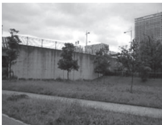
富士見橋たもと付近（監査人撮影）
