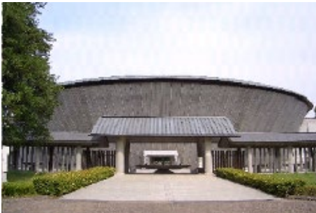
長期収蔵施設（多磨霊園みたま堂） 使用期間 30 年間（更新可能）の納骨堂です。
