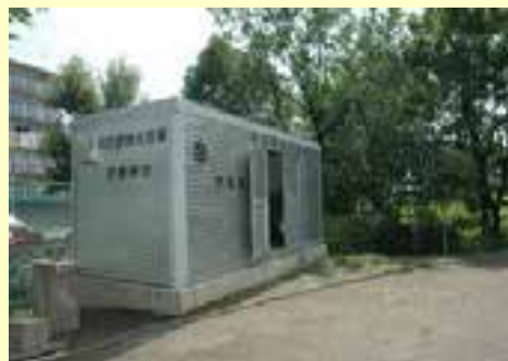
防災対応 (例：防災備蓄倉庫)
