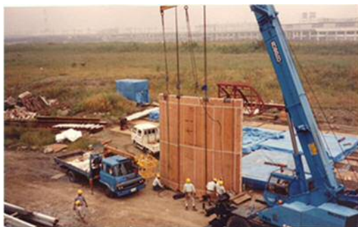
亚克力ガラスの現地搬入状況※
